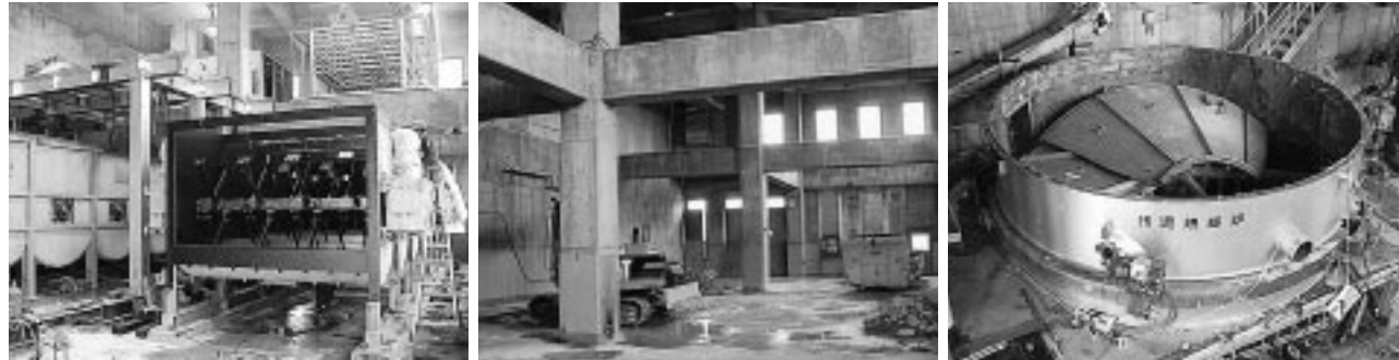
堆肥化機器設置状況
